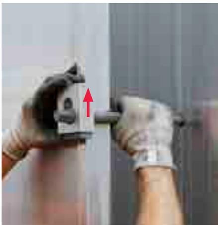
Segure a trava manual na posição superior. Aparafuse a âncora com a mão.
