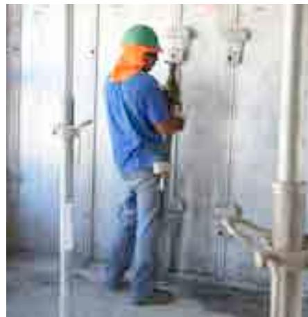
Se necessário, remova as escoras de Laje da Longarina para laje – Painel transição da área de Transição.
