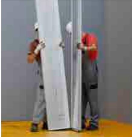
Empurre o segundo Painel Parede para o Perfil de Canto Externo e conecte-o através de Acoplamentos Parede.
