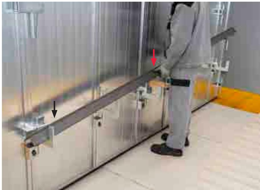
Insira o Perfil L (80x80x6) nos Acoplamentos Alinhadores previamente montados, ver B4.
