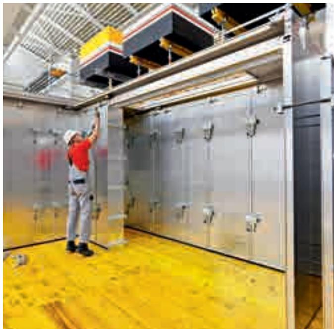
Conecte a Forma Lateral e o Pannel Parede com a Parede, Laje, Acoplamentos Parafuso, veja o desenho.
