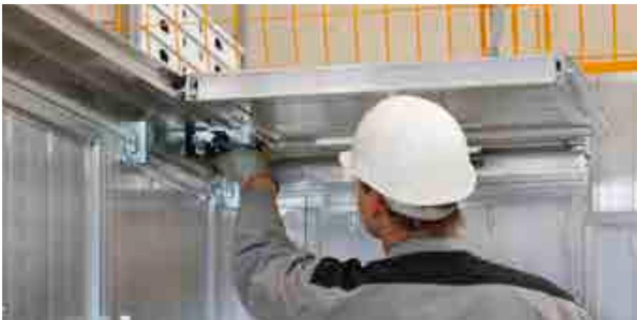
Posicione o Painel laje sem a Longarina para laje. Fixe com um Acoplamento Laje por lado do painel.
