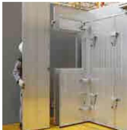
Posicione os Painéis Parede próximos às aberturas e conecte-os através de Acoplamentos Parede.
