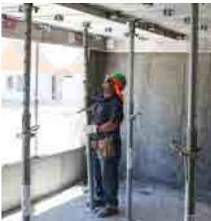
Posicione o suporte temporário antes de realizar o bloqueio. Um suporte temporário para 5 Painéis Laje, esquerda e direita.
