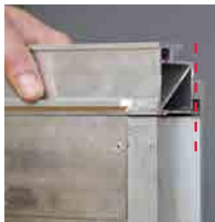
O Perfil do Canto Externo é nivelado com a borda superior do Painel Parede.
