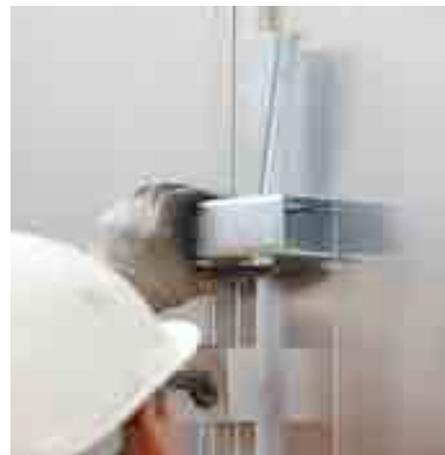
Coloque o Acoplamento Parede no Perfil de Borda com uma mão.
