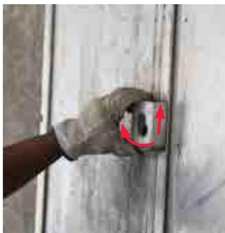
Remova a Luva da ancoragem – empurre a trava manual e desmonte girando para um lado.
