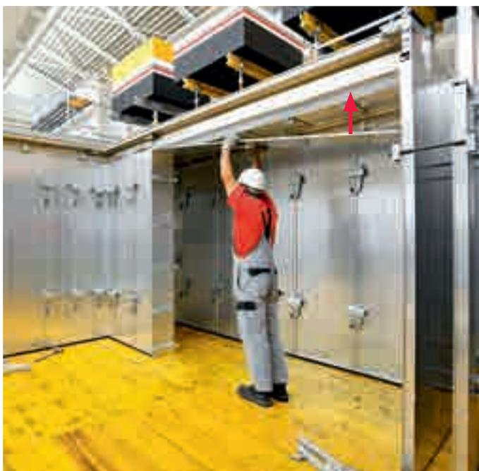
Levante a forma do fundo da viga (Perfil de Fechamento).
