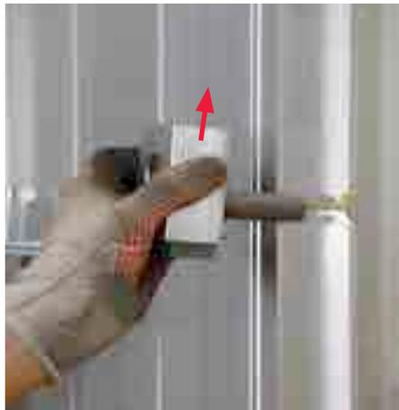
Coloque a Luva de Ancoragem com a trava manual previamente posicionada para cima.
