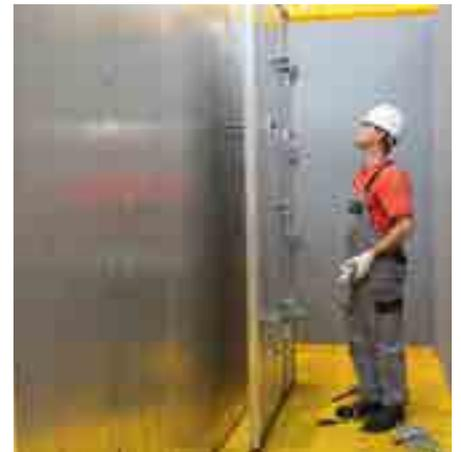
Conecte os Painéis com Acoplamentos Parede. Aperte as ancoragens.
