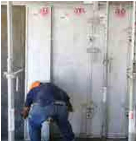
Desmonte os Painéis – remova o concreto de baixo para cima.
