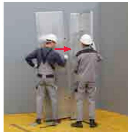
Empurre o Painel Parede com a Luva da Ancoragem nos recortes semicirculares do Painel de Canto. Realize os ajuste de altura necessários.
