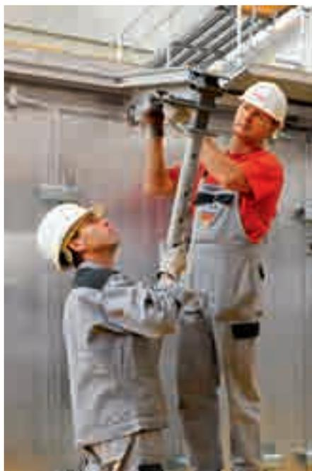
Monte a Escora com o Cabeçal Drop Head na Viga Longarina da Laje a partir de baixo.
