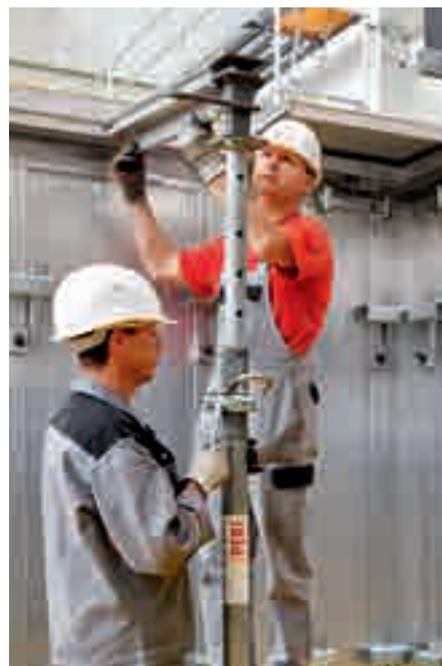
Coloque a Escora em uma posição perpendicular e rosqueie para alcançar a altura requerida até que a Viga Longarina da Laje esteja horizontal (nível de bolha)
