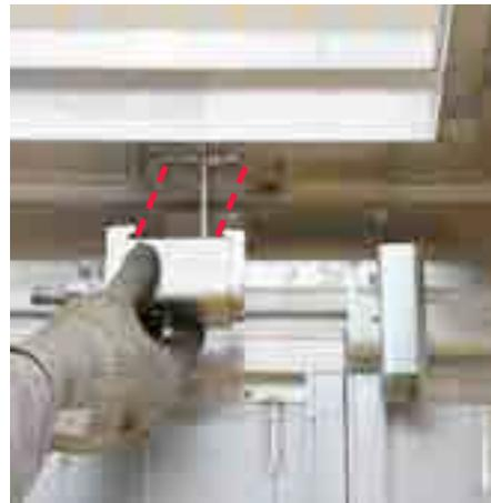
Empurre o Acoplamento Parafuso sobre o Perfil de Flange.
