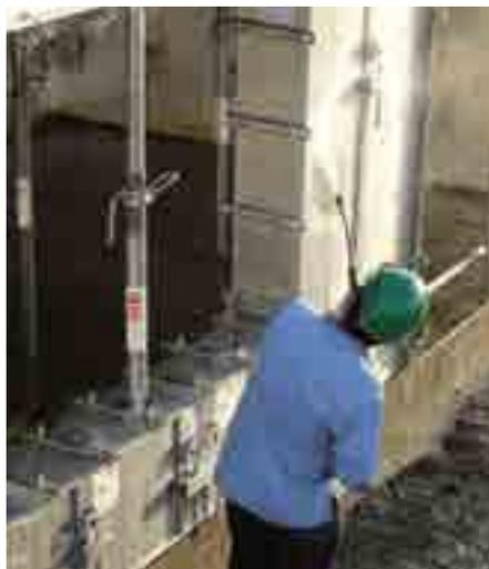
Limpe os Painéis imediatamente após a remoção, por exemplo, com uma espátula.
