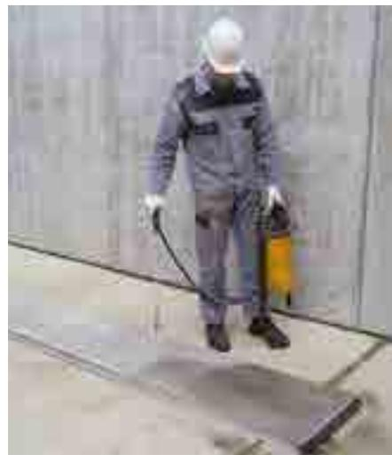
Limpe os Painéis com água imediatamente após a concretagem, por exemplo, com bocal de alta pressão.
