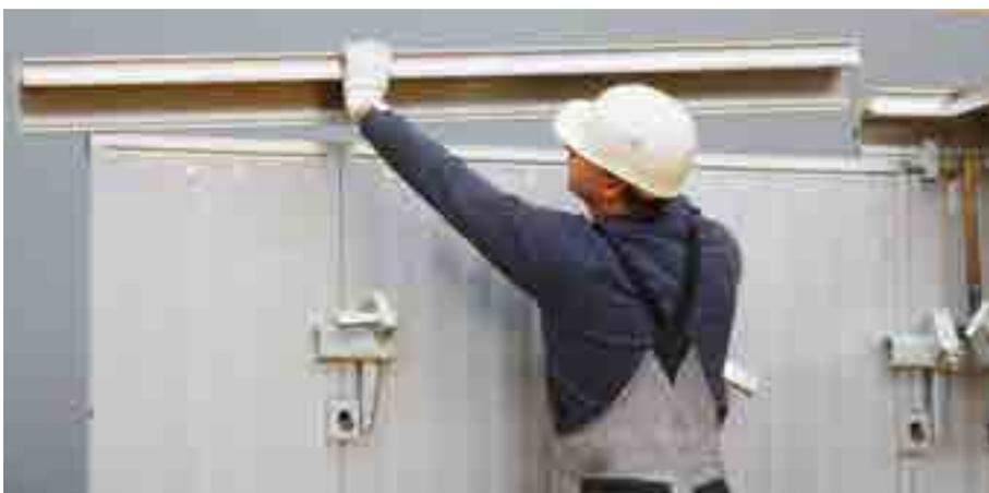
Coloque o Painel transição reto no Painel Parede.
