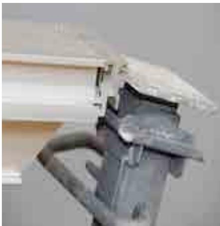
Alinhe o Cabeçal Drop Head nos eixos de viga.
