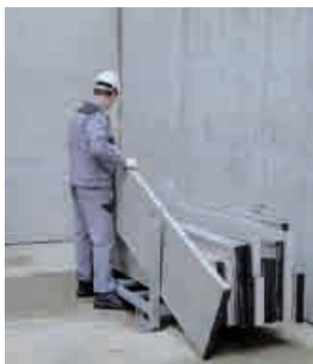
Armazene os Painéis verticalmente em pallets! Armazene os acessórios em gaiolas de pallet.
