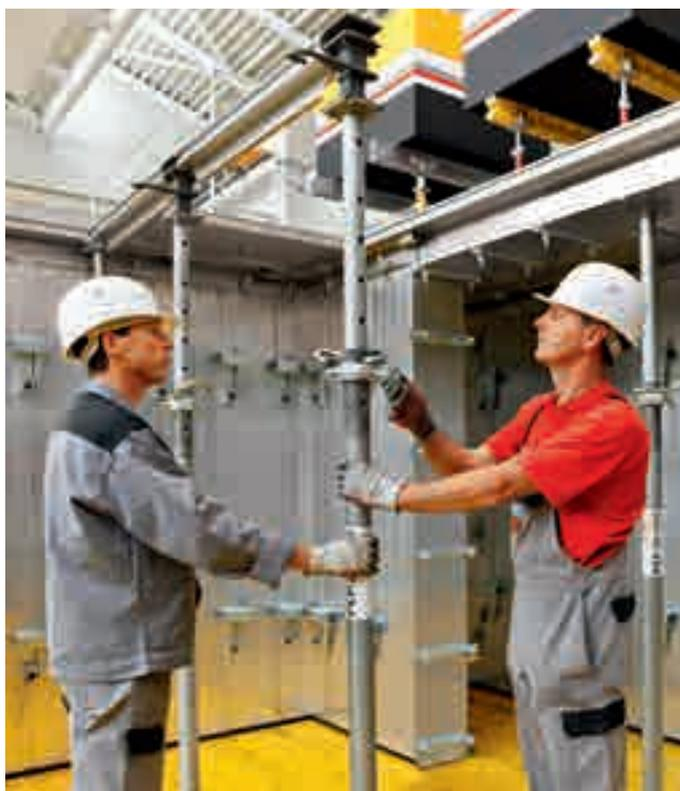
Posicione a escora de Laje em uma posição vertical e realize os ajustes de altura necessários.
