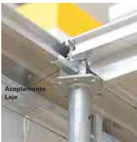
Conecte a Longarina e o Painel de Transição com Acoplamentos Laje e suporte com escoras de Laje.
