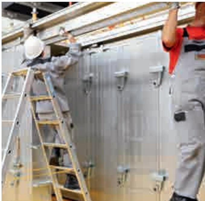
Levante o segundo conjunto de Forma Lateral para a viga.
