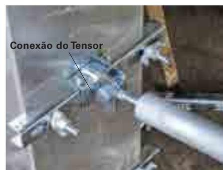
A conexão do Tensor é firmemente conectada à Longarina fechamento.
