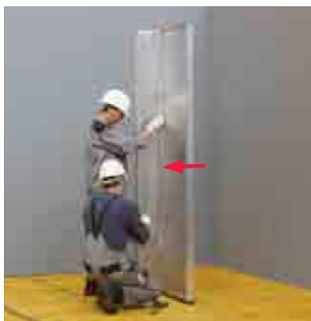
Empurre o próximo Painel Parede com recortes semicirculares sobre a Luva da ancoragem.
