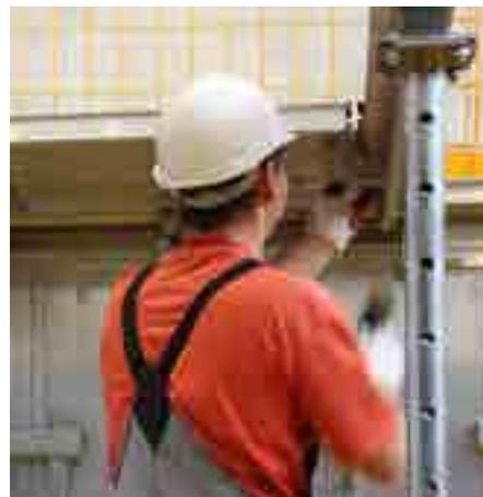
Coloque o Painel laje entre o Painel de Transição e a Longarina para laje.
