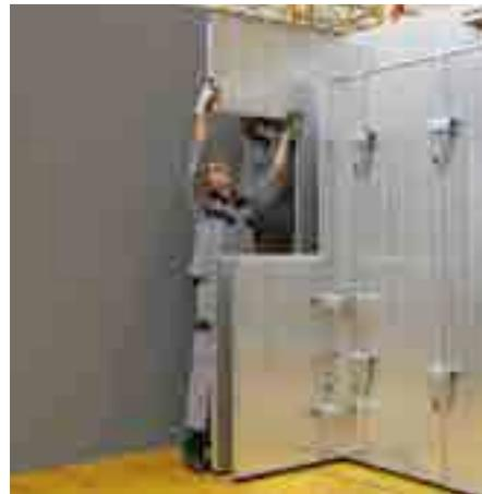
Monte o Acoplamento Parafuso no Painel Levante o Painel de Verga Externo. Conecte o Painel de Verga com os de Verga Externo.
