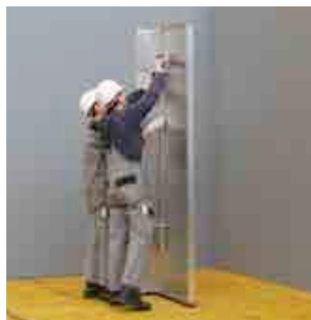
Conecte o Painel Parede e o Painel de Canto com os Acoplamentos Parede – veja o desenho para o número de Acoplamentos utilizado.
