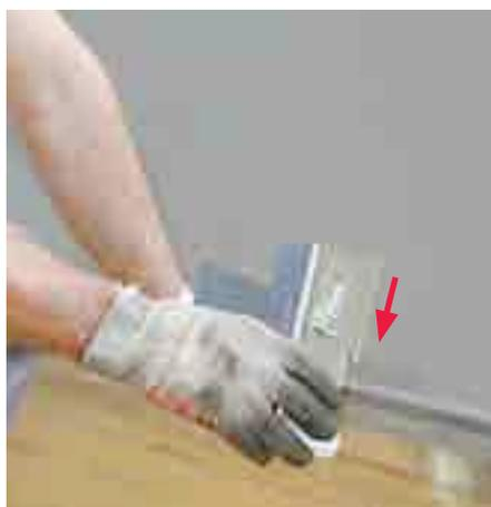
Conecte o Perfil do Canto Externo e Painel Parede com Acoplamentos Parede.
