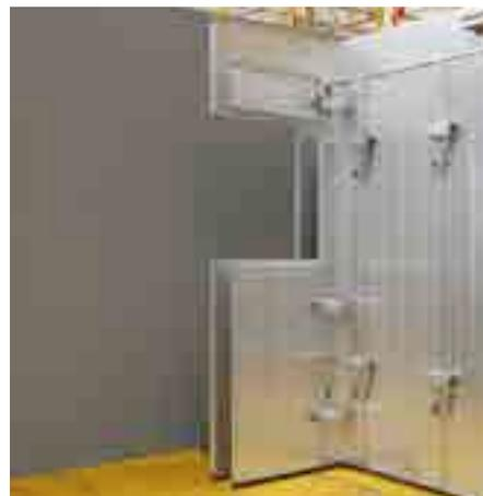
Levante o Painel de Verga Interno e fixe-o com os Acoplamentos Parede.
