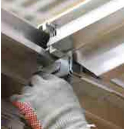
Conecte a Longarina para laje ao Painel transição com os Acoplamentos Laje.
