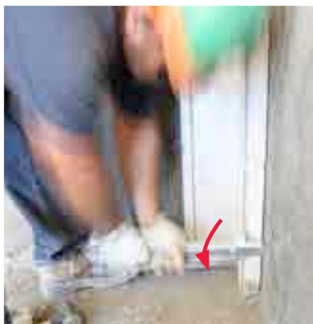
Empurre a Ferramenta de Desforma W/S para cima ou para baixo até que o painel seja liberado do concreto.
