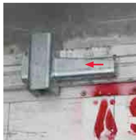
Remova os Acoplamentos Transição. Martele a cunha para a esquerda.
