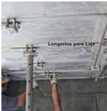
Fixe a extremidade livre do Painel laje com uma mão. Remova o Acoplamento Laje no painel adjacente.
