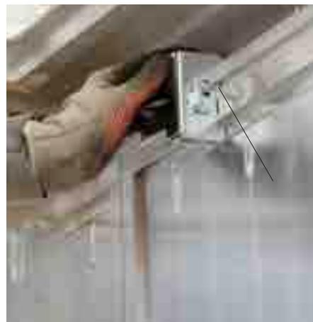
O Acoplamento Transição deve estar Firmemente posicionado na junta.
