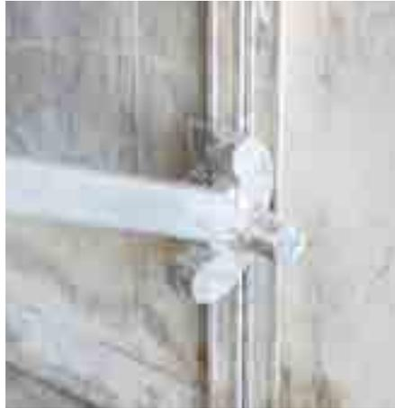
Conecte a Ferramenta de Desforma W/S com a garra no Perfil da Borda.
