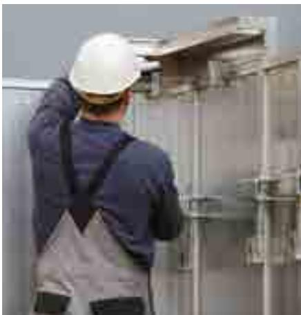
Instale o segundo Acoplamento Transição no outro lado da Parede.
