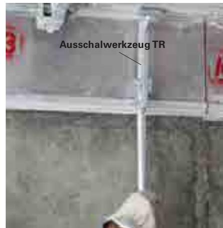
Solte o Painel transição do concreto através de uma Ferramenta de Bloqueio TR.
