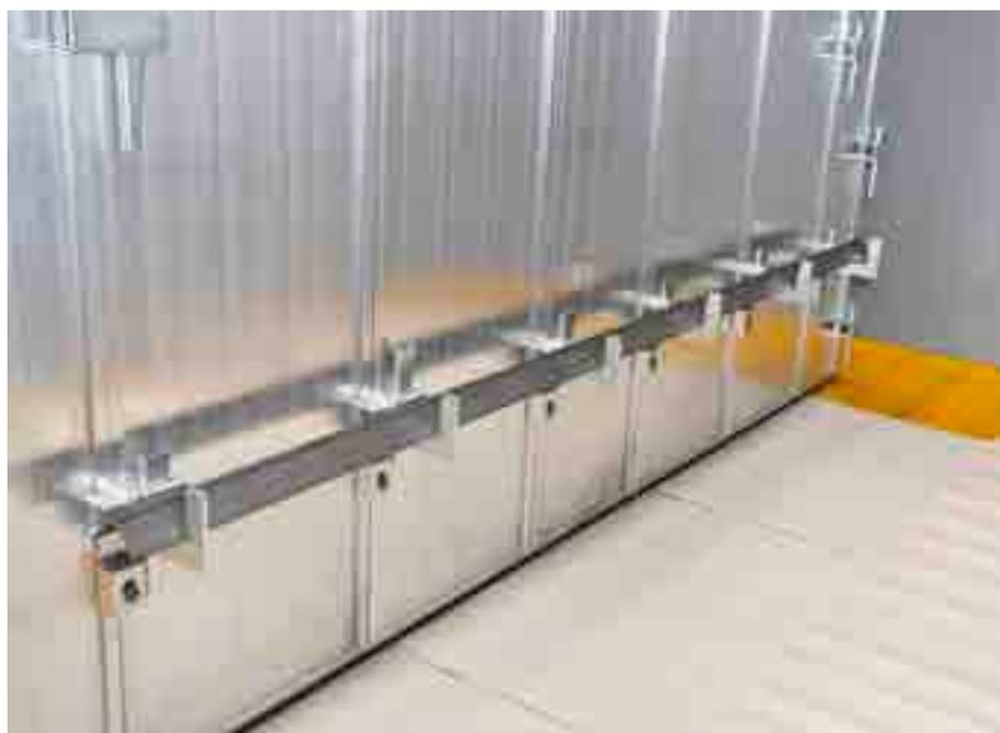
Mova os Acoplamentos Alinhadores para a borda inferior do Perfil L.
