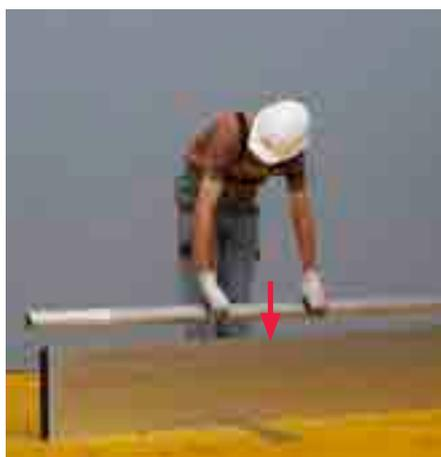
Coloque o Perfil de Canto Externo no Perfil da Borda do Painel Parede.
