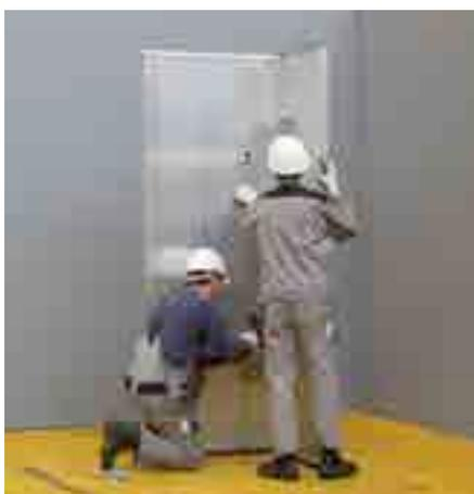
Conecte o Painel Parede e o Painel de Canto com os Acoplamentos Parede – veja o desenho para o número de Acoplamentos utilizado. Agora a área do canto interno está montada e na posição.
