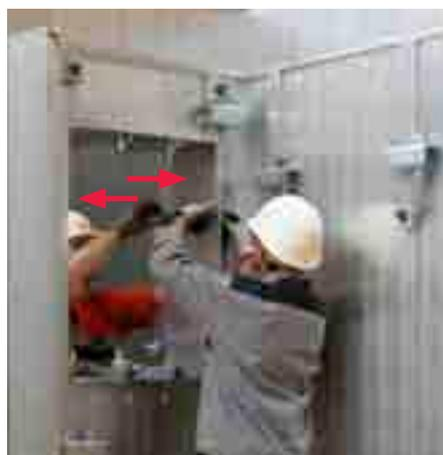
A placa lateral é posicionada entre a placa inferior e a placa superior.
