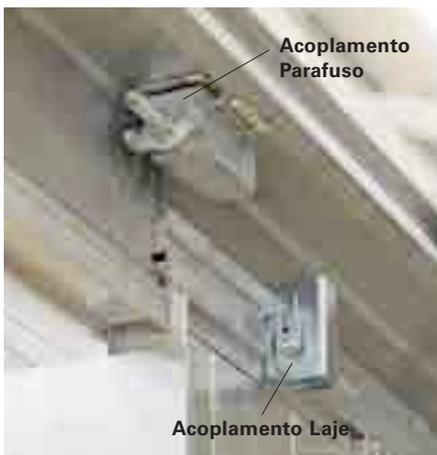
Conecte a Forma Lateral e o Painel Transição e Parede, com Acoplamento de Parede e Acoplamentos Parafuso, veja o desenho.
