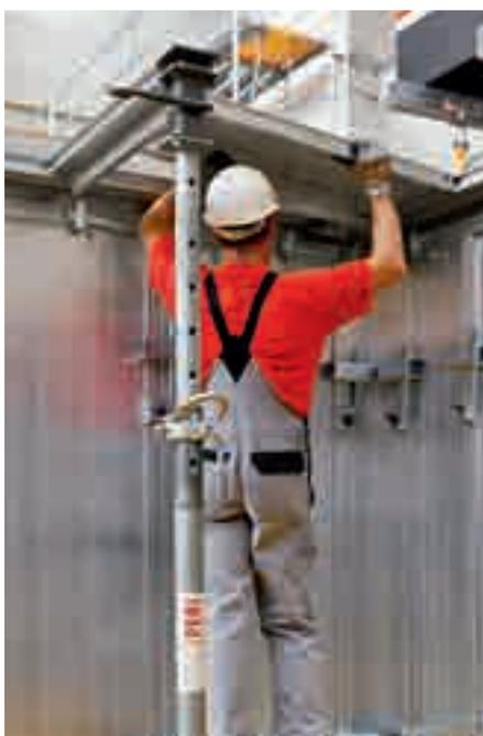
Insira o primeiro Painel laje e fixe nos três lados com os Acoplamentos Laje.
