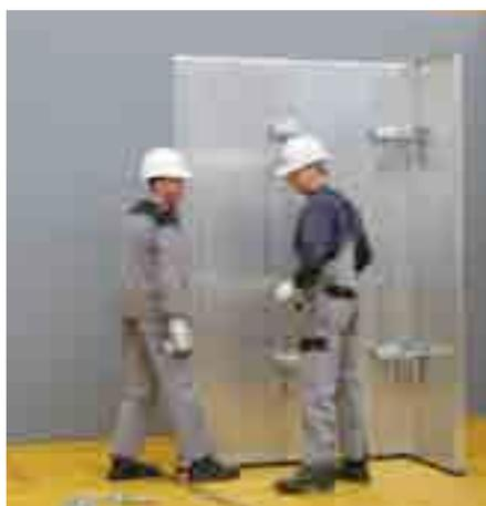
Conecte os Painéis com Acoplamentos Parede.
