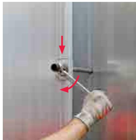
Empurre a trava manual para baixo. Aperte a ancoragem com a chave inglesa ou catraca.
