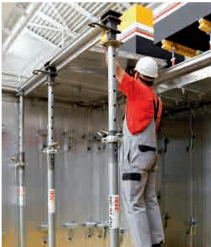
Monte o Painel laje e fixe com Acoplamentos Laje.
