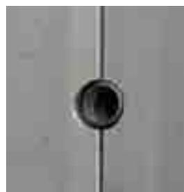
Quando os recortes de ancoragem semicirculares formarem um círculo, o ajuste de altura do Painel Parede foi concluído.
