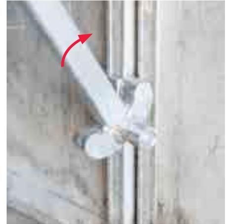
Empurre a Ferramenta de Desforma W/S para cima ou para baixo até que o painel seja liberado do concreto.
