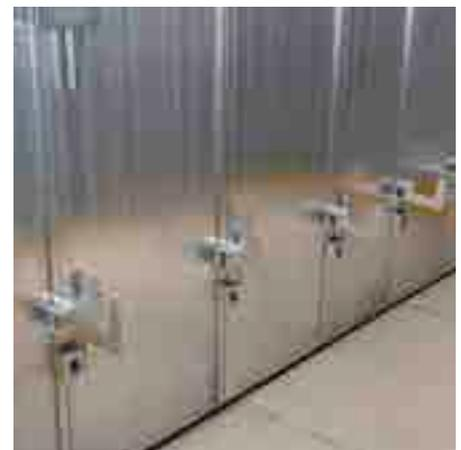
Instale Acoplamentos Alinhador em todas juntas de painel. Fixe da mesma forma que os Acoplamentos Parede.
