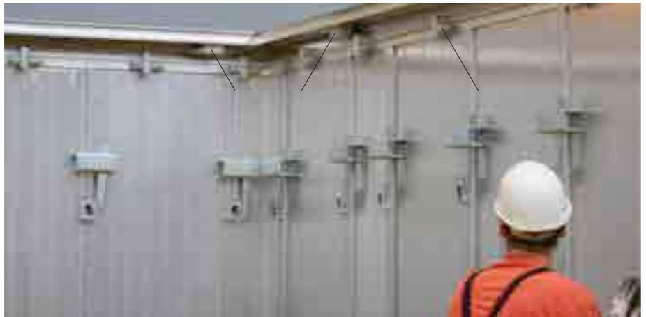
O Acoplamento Parafuso é instalado da mesma forma no segundo lado da Parede.
