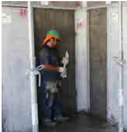
Remoção com a Ferramenta de Desforma W/S.
