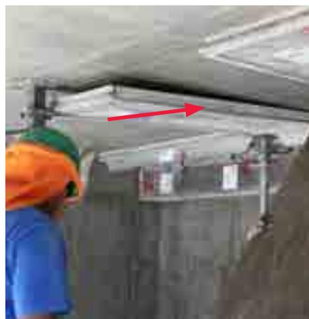
Empurre o Painel laje para os lados na área do Cabeçal Drop Head e então dobre para baixo.
