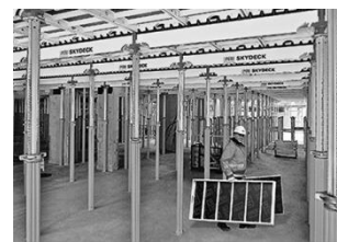
Cofragem de lajes
