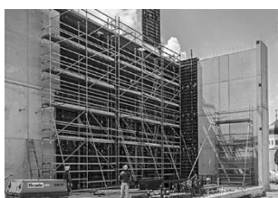
Construção de andaimes de trabalho
