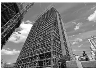
Fachada de andaimes de trabalho
