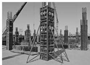
Cofragem de coluna
