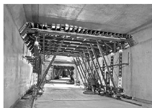
Cofragem de túnel
