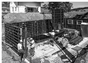
Cofragem de parede
