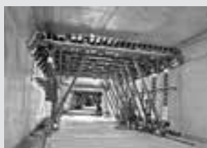
Cofragem para Túneis
