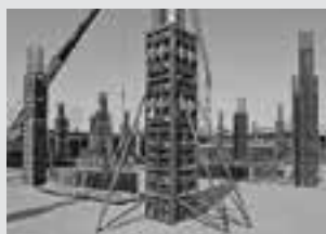
Cofragem para Pilares
