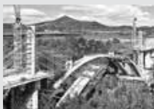
Cofragem para Pontes
