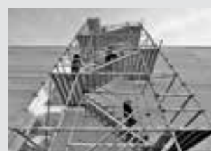
Escadas para acessos
