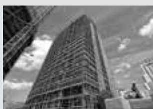
Andaime de Fachada
