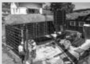
Cofragem para Muros
