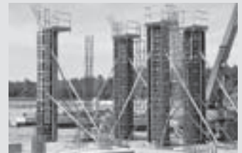
Cofragem para Pilares
