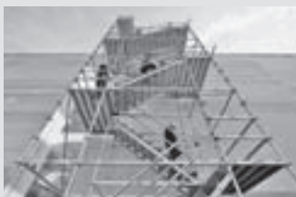
Escadas para acessos
