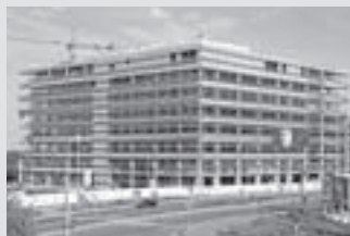
Andaime de Fachada
