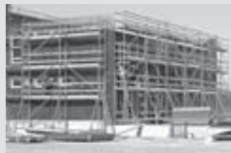
Andaime de Apoio
