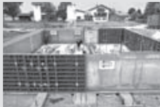
Cofragem para Muros
