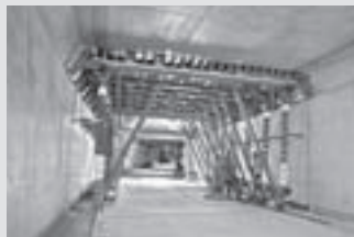
Cofragem para Túneis
