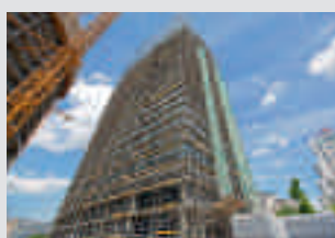
Andaime de Fachada
