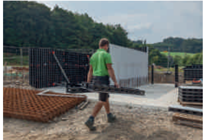
"Novos cofrageiros" vindos do sector da jardinagem e paisagismo utilizam o DUO para fazer reservatórios.
