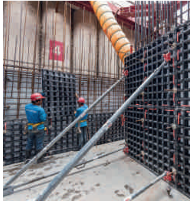
Baixo peso, elementos de cofragem pequenos – o DUO mostrou estas vantagens ao máximo com estas paredes da cave.
