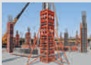
Cofragem para Pilares
