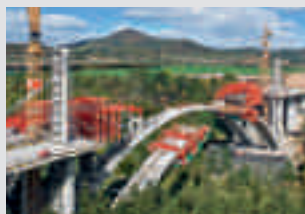
Cofragem para Pontes
