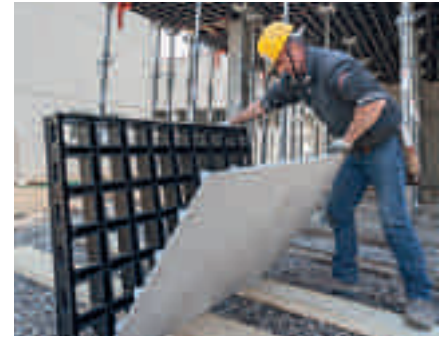
2. Remoção do forro danificado
