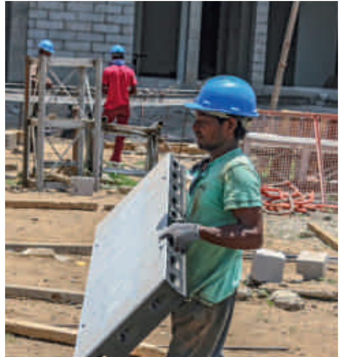
Rápida cofragem e descofragem na Índia
