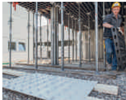
3. Posicionamento do novo forro
