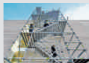
Escadas para acessos
