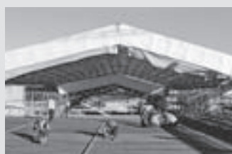
Andaime de Protecção
