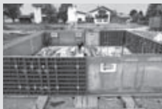
Cofragem para Muros
