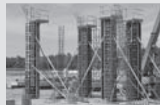
Cofragem para Pilares
