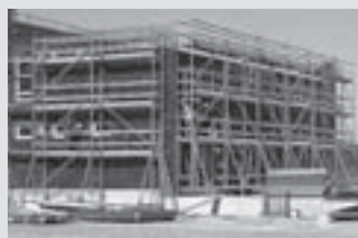
Andaime de Apoio
