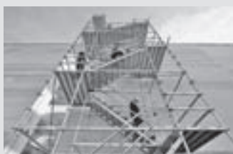
Escadas para acessos
