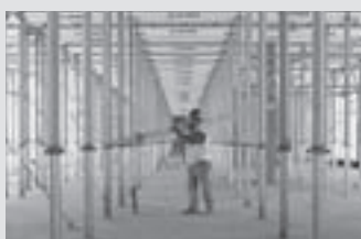
Cofragem para Lajes
