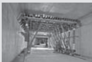
Cofragem para Túneis
