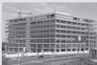
Andaime de Fachada
